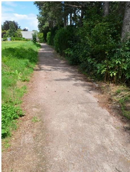
Abb. 341 Friedhof Schiefbahn, Zugangsweg Parkplatz zum Friedhof, Deck- und Tragschicht in Auflösung, Komplettsanierung notwendig
