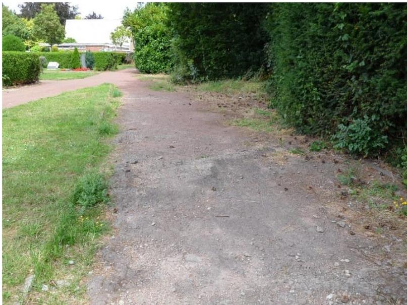
Abb. 342 Friedhof Schiefbahn; Zugangsweg Parkplatz zum Friedhof, Deck- und Tragschicht in Auflösung, Komplettsanierung notwendig
