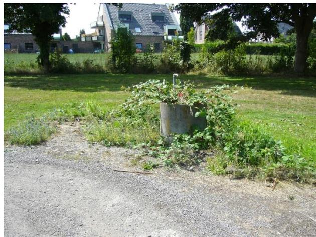
Abb. 385 Friedhof Willich, Schöpfbecken ohne Funktion im Bereich unbesetzter Grabfelder, kann demontiert werden
